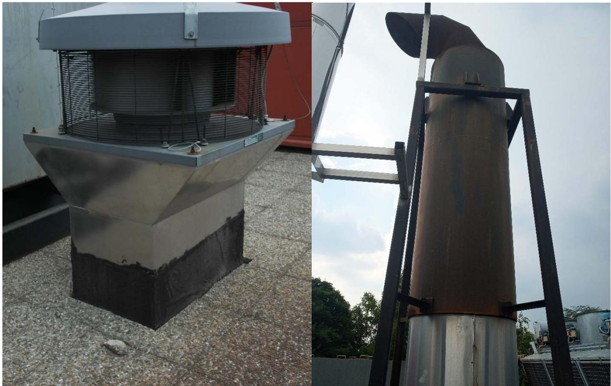
Figura 7: particolare espulsione fumi, marmitta scarico motori
