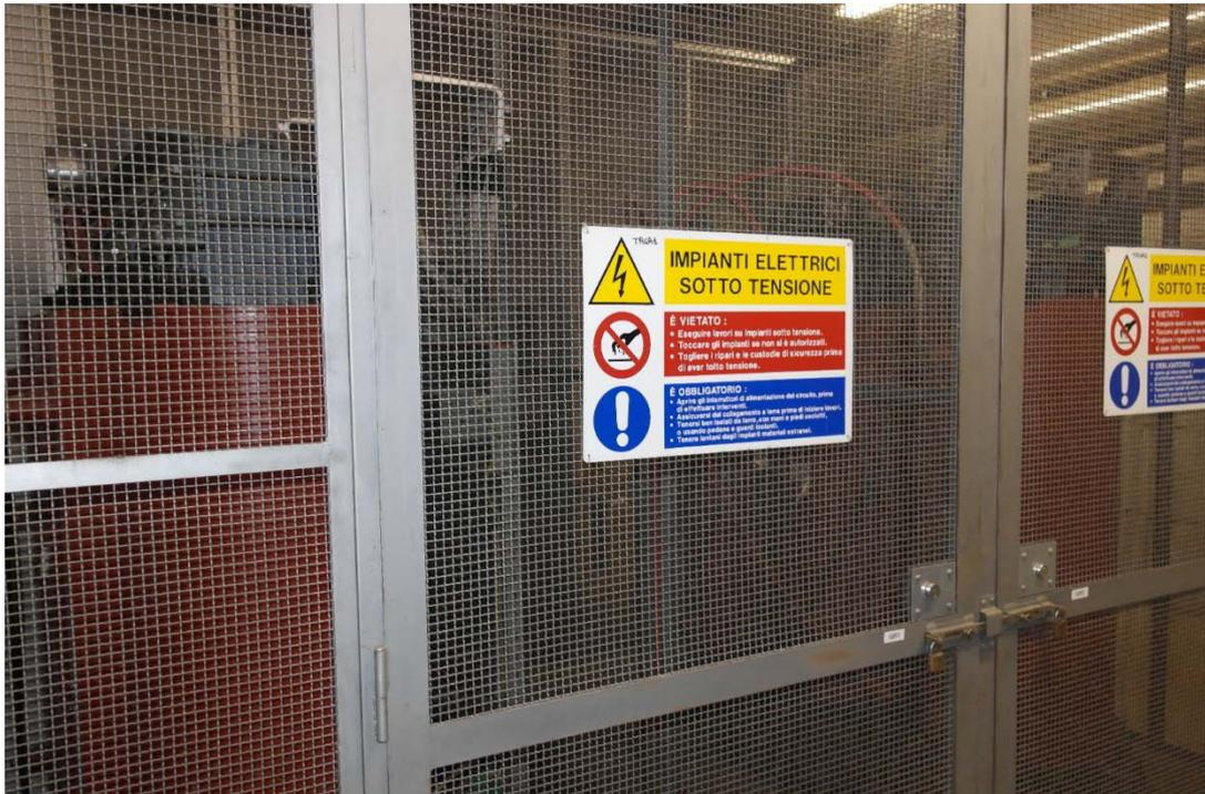
Figura 9: particolare gabbia trasformazione 15Kv/400v
