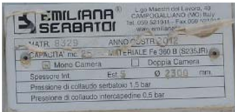
Figura 12: particolare targa cisterna di stoccaggio oli
