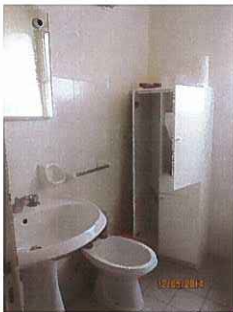
Foto 28: Bagno primo piano
