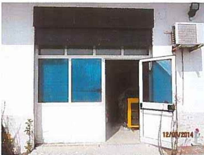
Foto 4: Ingresso primo locale del piano terra
