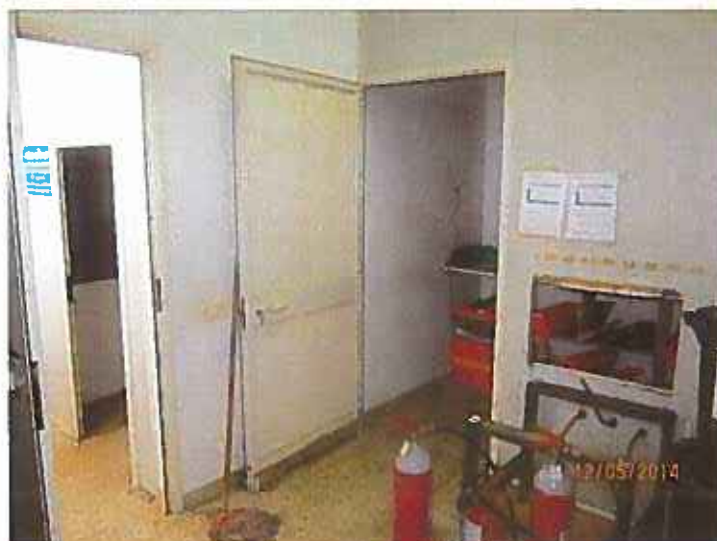
Foto 9. Interno secondo locale del piano terra
