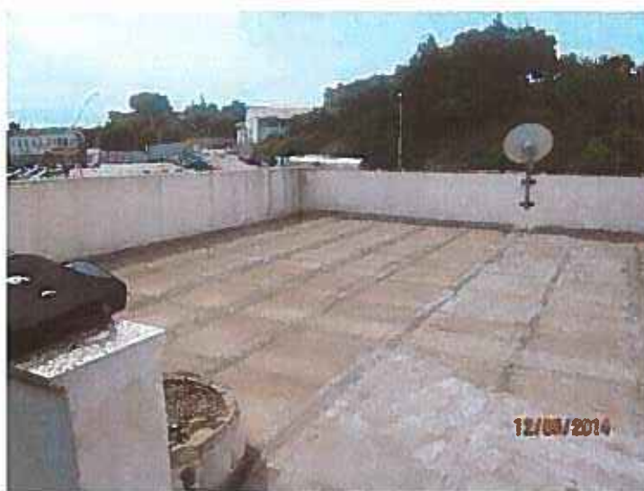
Foto 25: Lastrico solare con guaina bituminosa
