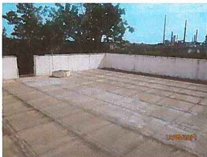
Foto 26: Lastrico solare con guaina bituminosa
