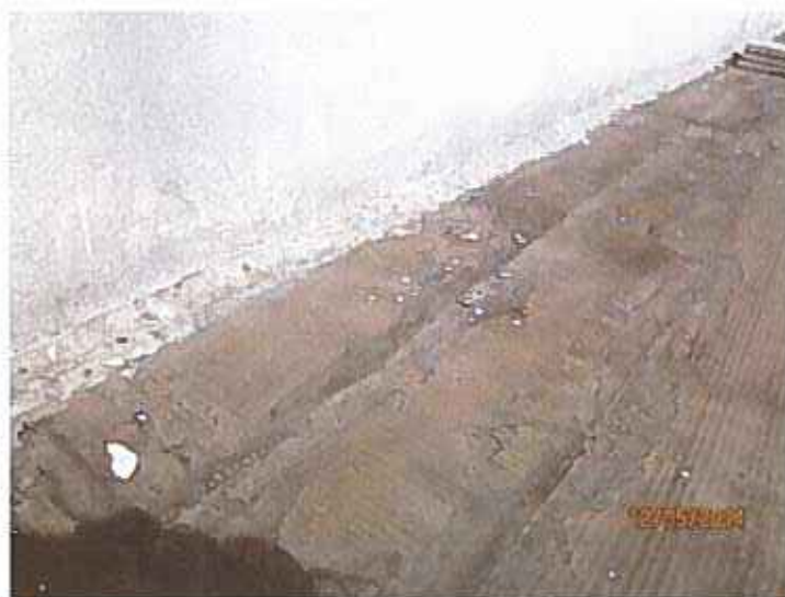
Foto 27: Particolare lastrico solare con guaina bituminosa
