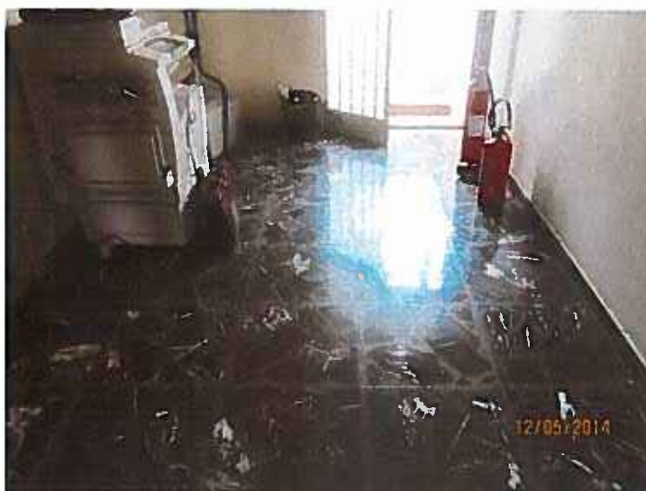
Foto 22: Particolare pavimentazione interna
