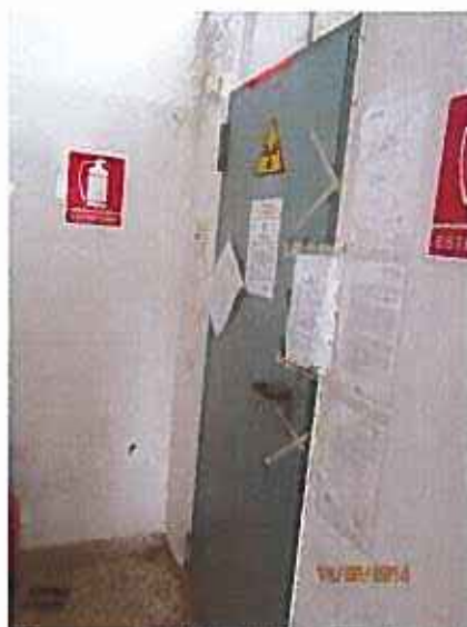
Foto 11: Interno secondo locale del piano terra ingresso bunker
