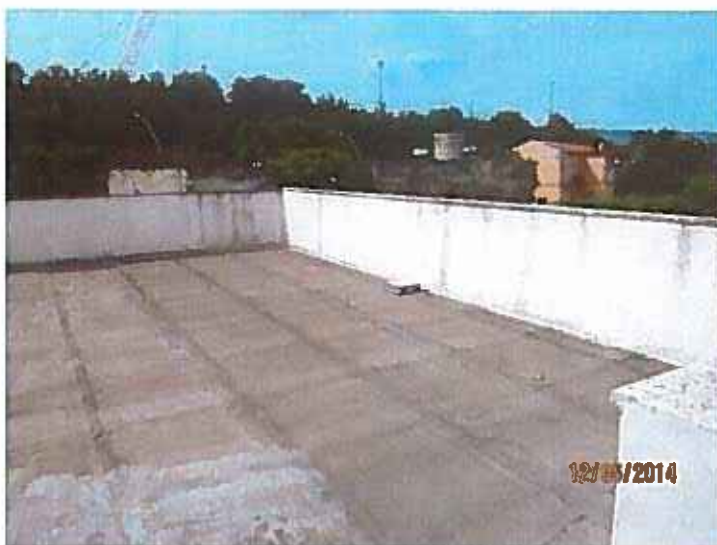
Foto 24: Lastrico solare con guaina bituminosa
