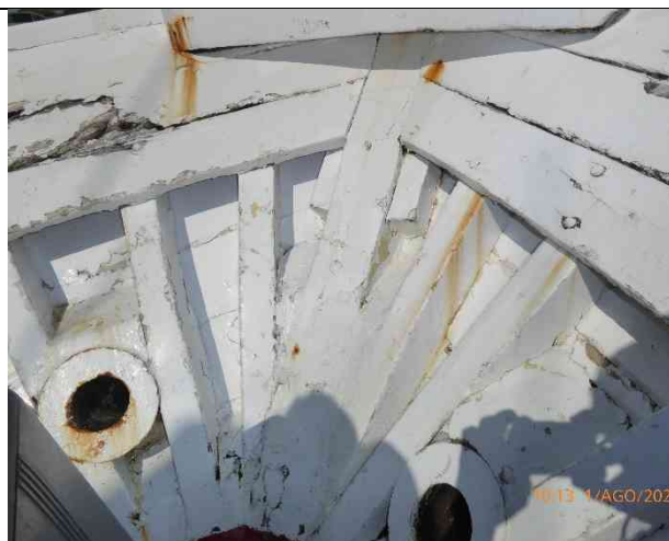
Fotografia 18 – Strutture della prora
