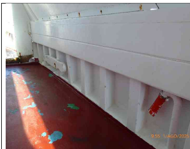
Fotografia 19 – Strutture della coperta
