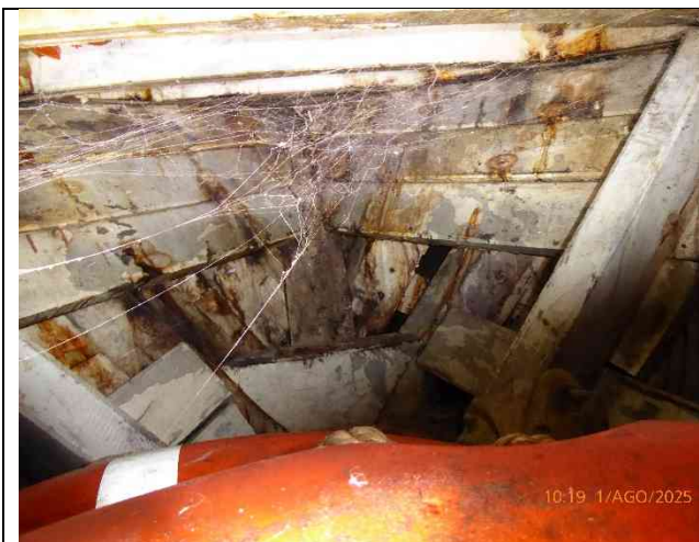
Fotografia 32 – Strutture interne della prora
