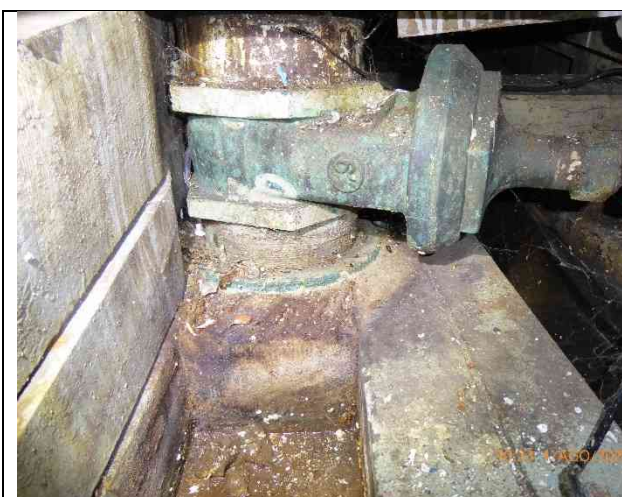
Fotografia 42 – Valvola aspirazione acqua lavaggio
