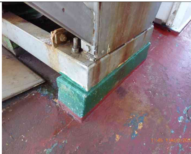
Fotografia 23 – Supporto del verricello
