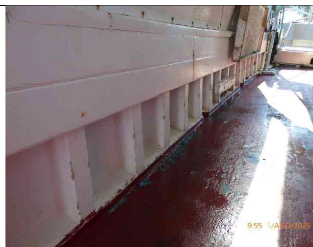
Fotografia 20 – Strutture della coperta
