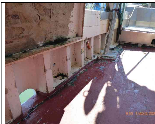
Fotografia 21 – Strutture della coperta
