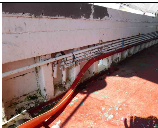
Fotografia 22 – Strutture della coperta
