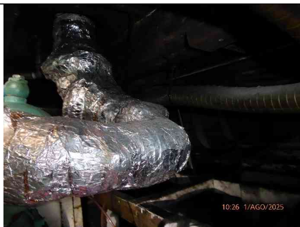
Fotografia 53 – Collettore gas di scarico
