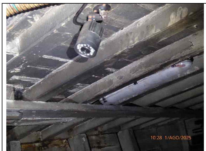
Fotografia 8 – Telecamera per vidoesorveglianza
