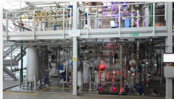
Stanowisko usuwania CO 2 – 100 m 3 /h (2012)
