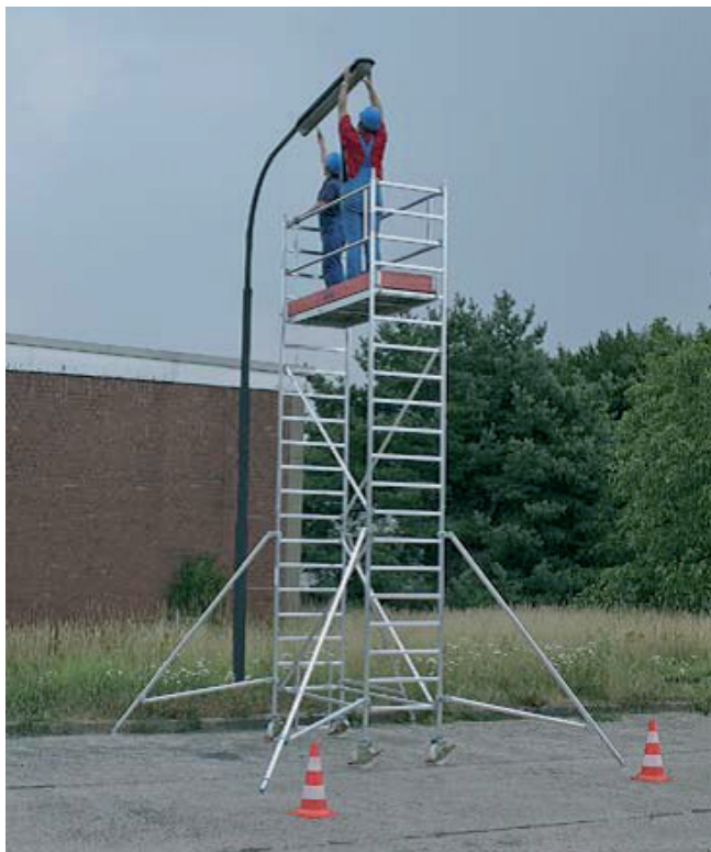
Rys. 5. Rusztowanie przejezdne do prac na wysokości do 14 metrów ( krauze-system.pl )
