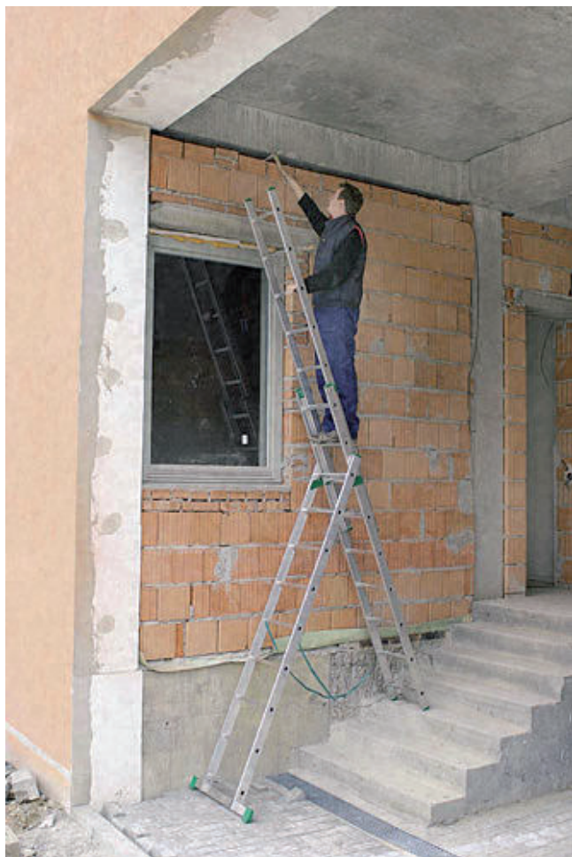
Rys. 2. Rozstawna drabina przystosowana do ustawienia na schodach, wyposażona w stopki antypoślizgowe oraz linki łączące dolne części (Domena)
