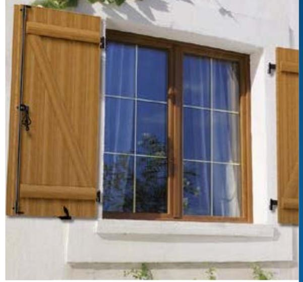
Volets en configuration Barres et écharpe plaxé, ferrage en noir.
