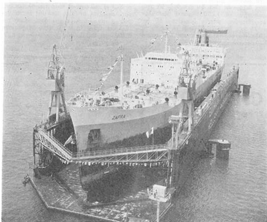
Η δεξαμενή έν λειτουργία: Τό πρώτον δεξαμενισθέν τάνκερ της «Σέλλ».
