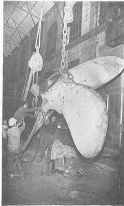
Τό ναυπηγείον **TSAKOS INDUSTRIAS NAVALES S.A.** κατασκευάζει και έπισκευάζει έλικας από πολλών δεκαετιών. Είς τήν φωτογραφίαν, ή έλιξ, διαμέτρου 5.10 μέτρων και δάρους 12 τόνων, τού **M/V PUNTA ATALAYA** μετά τήν συγκόλλησην νέου τεμαχίου 130 έκ. X 60 έκ. είς τό ανω δεξιόν πτερύγιον. Η έργασία έγένετο είς τό χυτήριον τού ναυπηγείου ήπο τήν έποπτειάν τού Νορβηγικού Νησιονάμονος.
