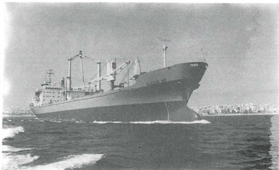
Τό νεότευκτο πολλαπλής χρήσεως «Κλέλια Χφ.» 16.900 τόν. d.w., 13.453 τόν. γκρός, τό όποιο παραδόθηκε στους πλοιοκτήτες του «Seaways Shipping Enterprises» άπό τά ναυπηγεία της Βάρνας τόν Μάιο και στίς 10 Ίουνίου ύψωσε έλληνική σημαία.
