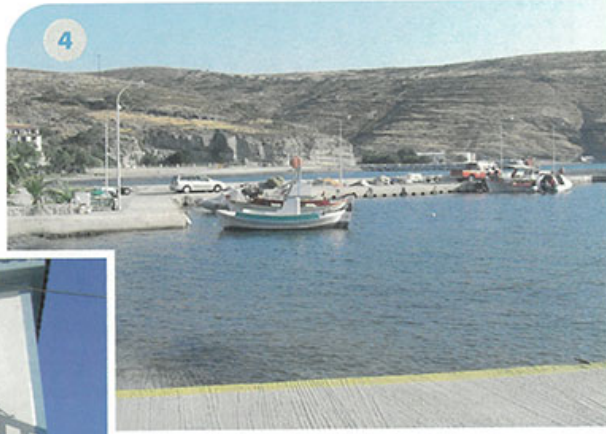
4. Το λιμάνι καλύπτει με δυσκολία τις σύγχρονες ανάγκες του νησιού. Η κυβέρνηση έχει δεσμευθεί ότι σε λίγα χρόνια θα ολοκληρωθούν τα έργα για τη δημιουργία νέου λιμένα, ο οποίος θα εξυπηρετεί και υδροπλάνα!
