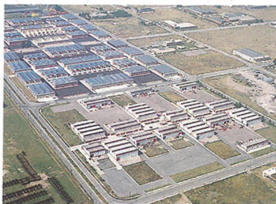
Βιοτεχνικά κτίρια ΒΙ.ΠΕ. Θεσσαλονίκης.
