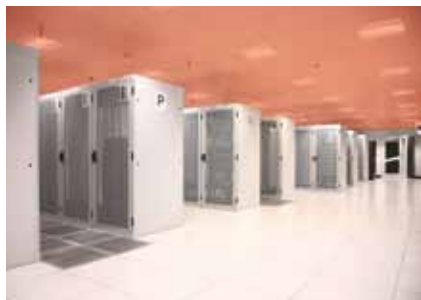
Zabezpieczenie sufitu w serwerowni
