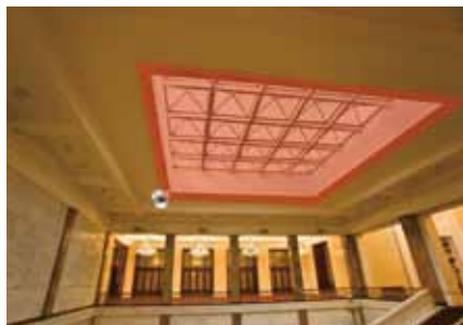
Zabezpieczenie świetlika w budynku / magazynie
