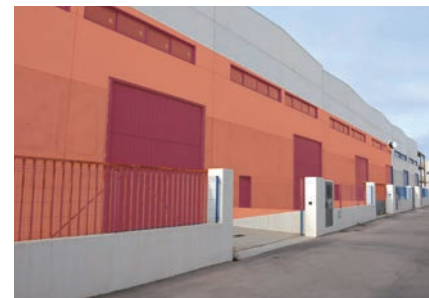
Zabezpieczenie zewnętrznych ścian magazynu
