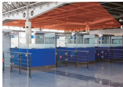
Zabezpieczenie strefy kontroli dokumentów
