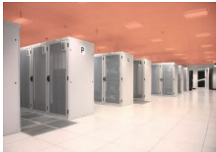
Deckenabsicherung in einem Rechenzentrum
