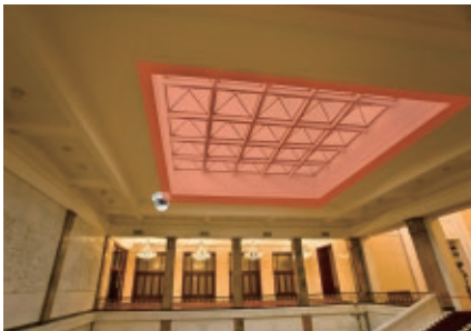
Oberlicht-/Dachfensterabsicherung in einer öffentlichen Einrichtung/einem Lager
