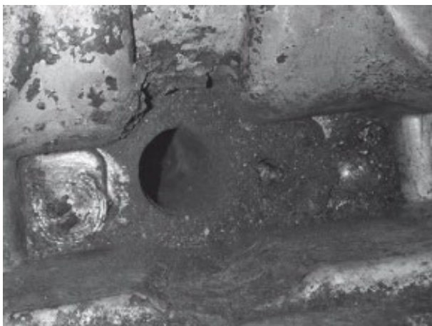
Antes de la limpieza
