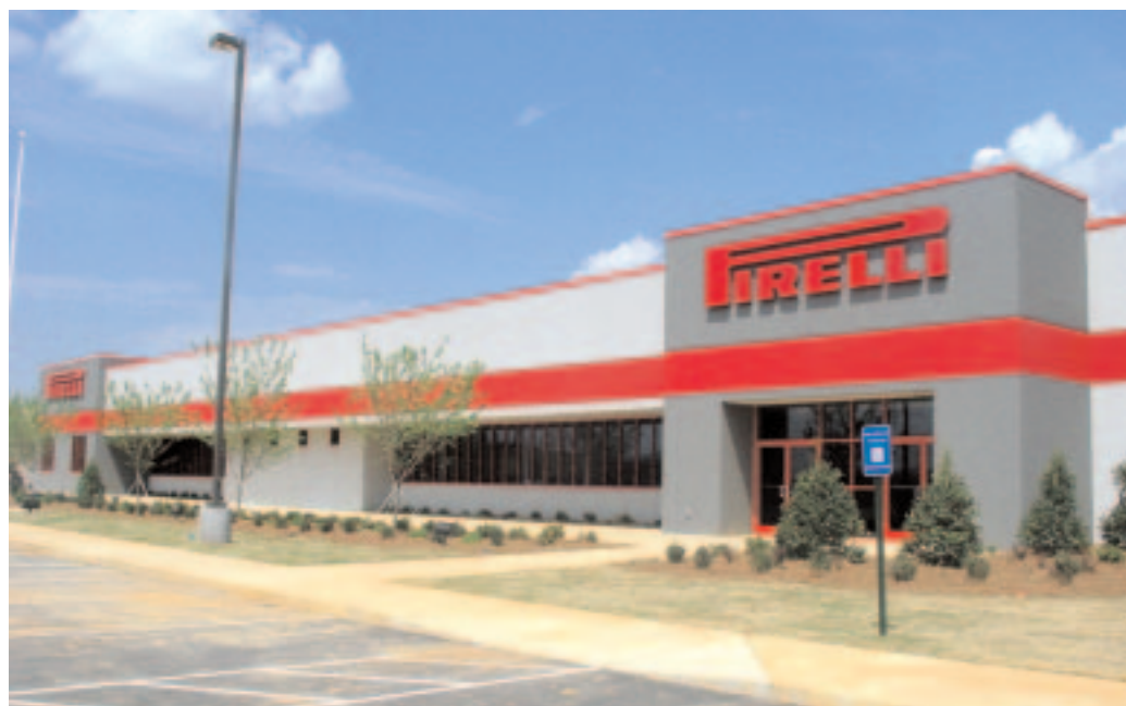
È operativa a Rome, Georgia (Stati Uniti), la prima fabbrica MIRS™ installata oltreoceano.
