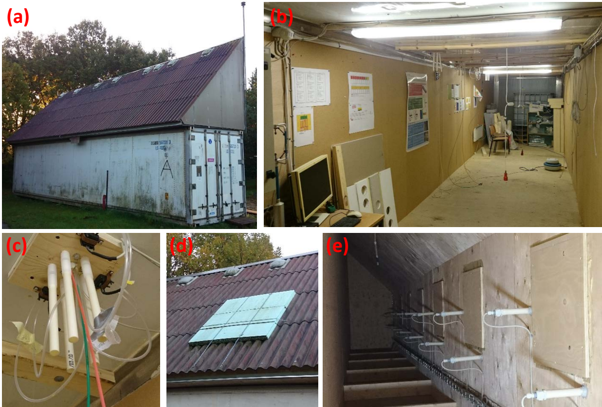
Figur 1: Test container A ude fra (a), Test container B inde fra (b), Anordning til kontrolleret infiltration (c), Skunkrum med udvendig isolering (d), Loft korridor med adgangsllemme til skunkrummene (e).
