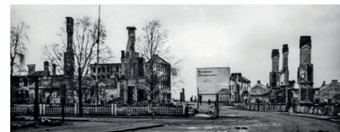
Valtakatu Lapin sodan jälkeen syksyllä 1944. Vasemmalla Pohjoismaiden Osakepankin rauniot, oikealla kauppalantalon rauniot. Takana Rovaniemen Osuuskauppa ja Pohjolan Osakepankki osittain pystyssä. Kuvaaja: Werner Öhrling
