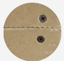
Gipskartonplatten und Bohrlöcher
