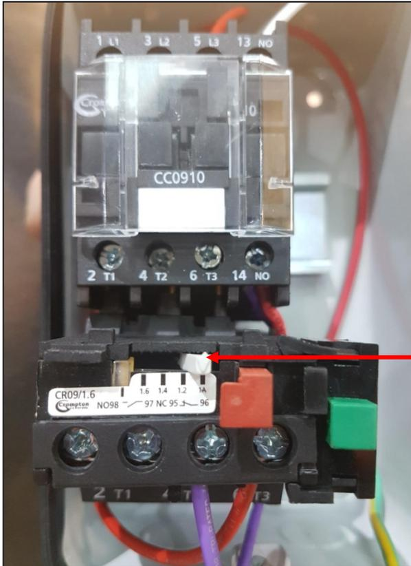
Para ajustar, saque el selector y deslícelo a la posición requerida
