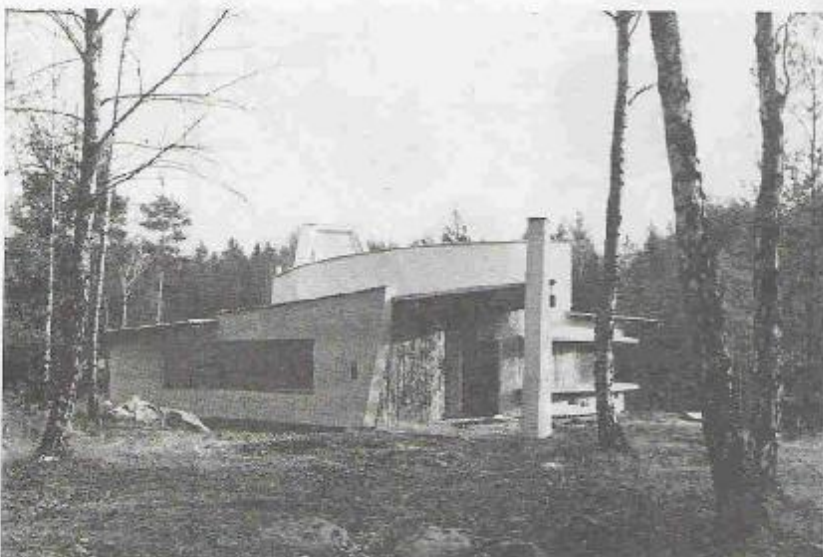
Pohled od severovýchodu
