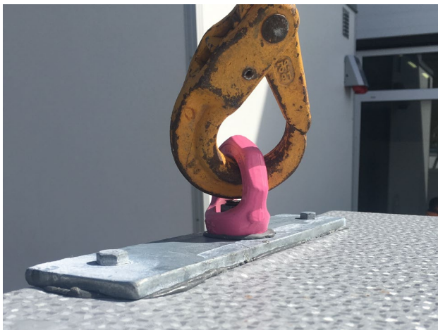
Gjennomgående stålstag i vegg. Løfteøye RUD VRM M-16 1,5 T
