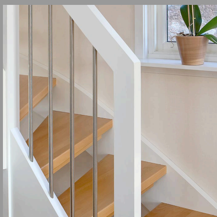
16. Sammenhengende megler og håndløper. Baluster i stål.
