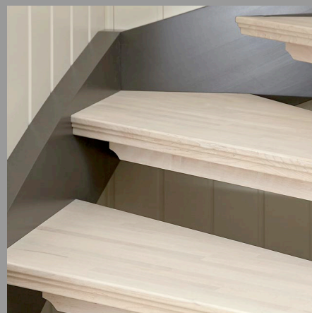
3. Profilert barnesikring og profilert trappenese.
