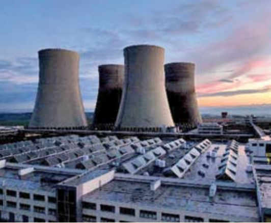
De Temelin 2 centrale
