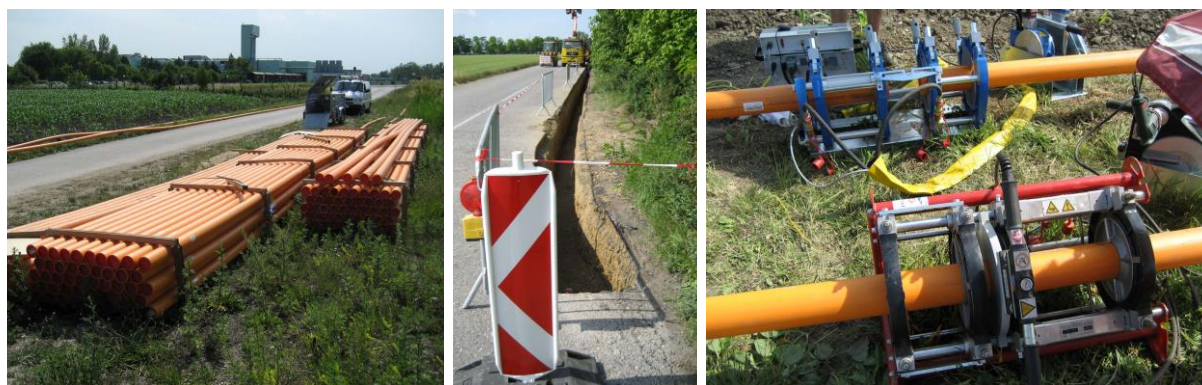
Figur 10: Rörledning för biometan i Bruck/Leitha, Österrike under uppförande; rören svetsas ihop (till höger). Källa: Wiens tekniska högskola
