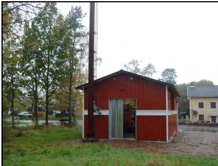
Bild 2 Närvärmeanläggningen i Torpsbruk. Idén att färglägga byggnaden med röd färg och vita knutar gör att pannhuset smälter in i den miljö det befinner sig i. (Foto: T. Andersson)
