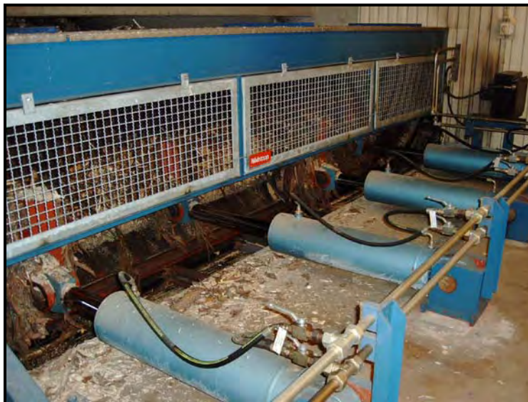
Bild 3 Bränsleskraporna på närvärmeanläggningen i Moheda. (Foto: T. Andersson)
