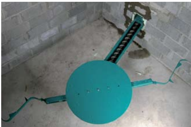
När man tittar ner i bränslelagret ser man den roterande armen och skruven.
