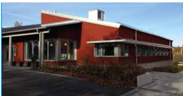
Mönsterås bibliotek med passivhusstandard Foto: Gunnar Thernström, Mönsterås
