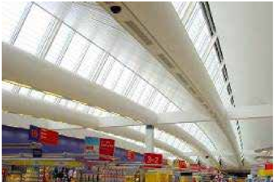
Källa: IDEA (installation på Sainsbury's, Greenwich, England)
