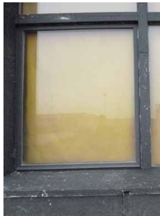
Tilläggsisolerat fönster steg 1 och 2.
