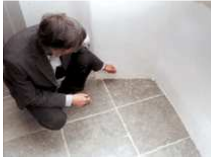
Lars Almqvist visar att rören till "Temperierung"-systemet finns inne i väggen.
