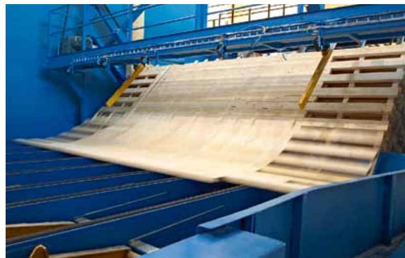
Rrrrrutsch! Schon wird das nächste Paket abgestapelt, das in einem der sechs Valutec-Kanaltrockner auf die Zielfeuchte gebracht wurde
