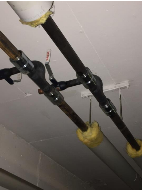
Bild 4. Ledningarna med Haeloks presskopplingar efter slutfört test 20150901.
