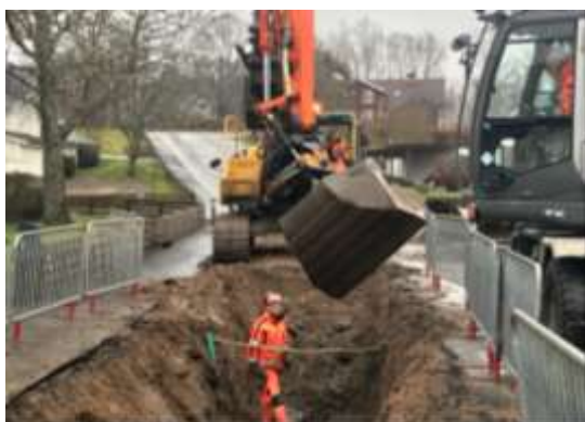
Ledningsarbete, Otto Holm området, Osby
