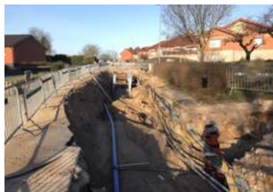
Ledningsarbete Öllers väg, Näsrum
