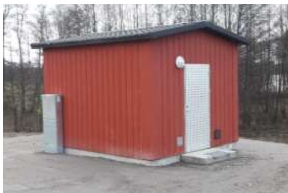
Nya pumpstationen vid Råby 11
