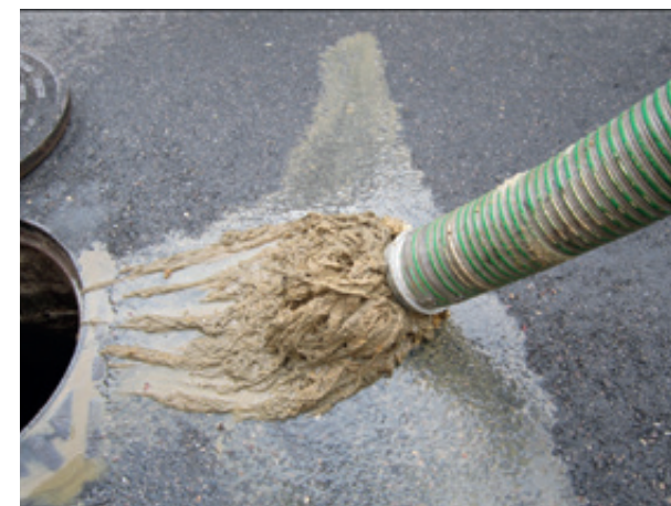
Lingettes sur la pompe du poste de relevage.
