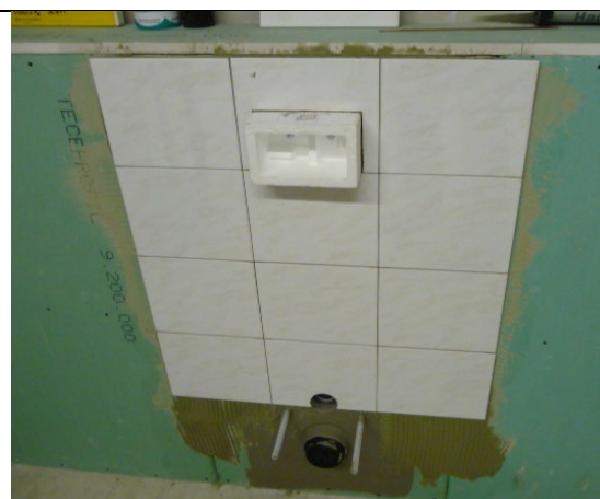
6b. Andre trinn av flismontasjen
