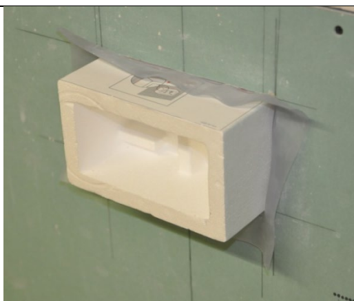
2a. For størrelse på åpning, se målskjema på isoporen.
