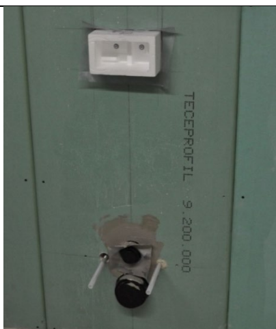
4. Påfør smøremembran på de aktuelle stedene.
