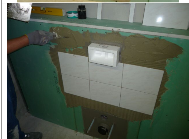
6a. Første trinn av flismontasjen
