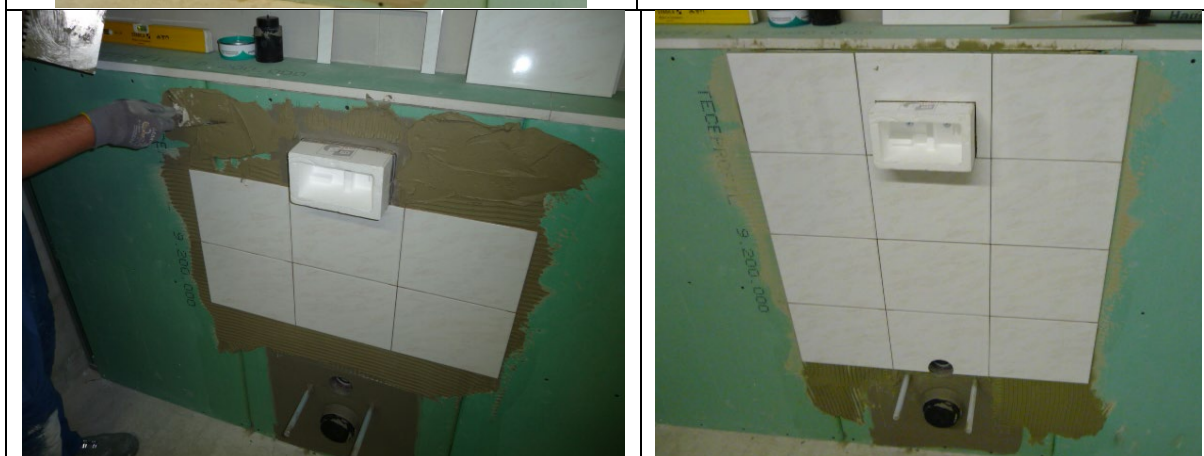
6a. Første trinn av flismontasjen
