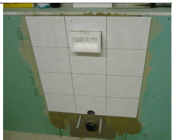
6b. Andre trinn av flismontasjen
