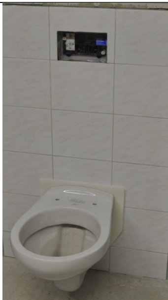
9b. Monter klosettet og skru det inn mot veggen.
