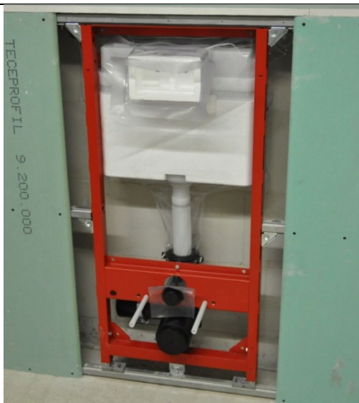
1. Installer WC-modulen i vegg.
