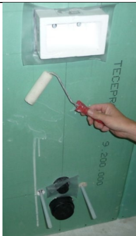
3. Påfør primer på frontplaten
