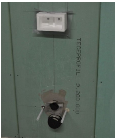
4. Påfør smøremembran på de aktuelle stedene.
