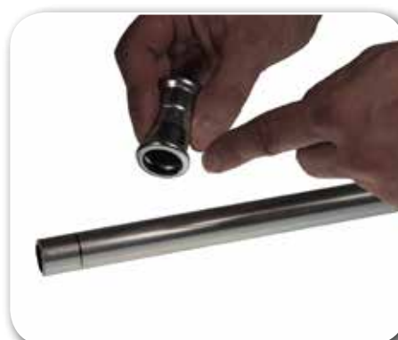
Figur 7: Kontroller fitting/rør
