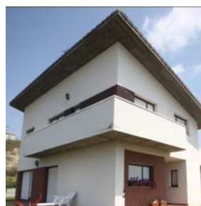
Chalets pareados (15 viviendas en Manzanos - Álava)
