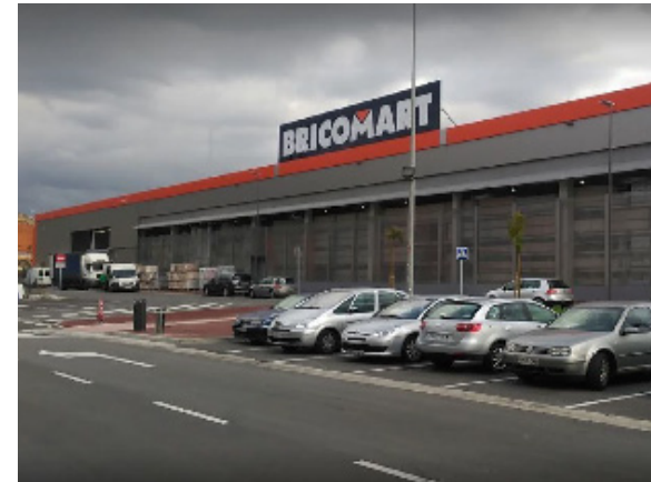
Bricomart en Sestao Superficie: 15.322,25 m 2 (Pabellón: 8.477 m 2 , playa: 6.845,25 m 2 )
