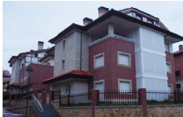
2 edificios de 6 y 3 viviendas en UE-CR-22 La Cruz de Galdakao 9 viviendas, garajes y trasteros
