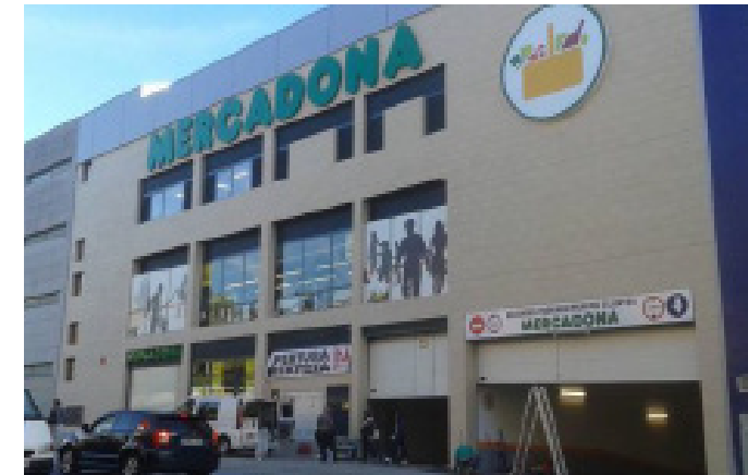
Mercadona en Bolueta (Bilbao) Superficie tienda: 3.000 m 2 Garaje: 4.500 m 2 Oficinas: 450 m 2
