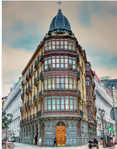
Rehabilitación de edificio en Alameda Urkijo 11 (Bilbao) 12 viviendas libres
