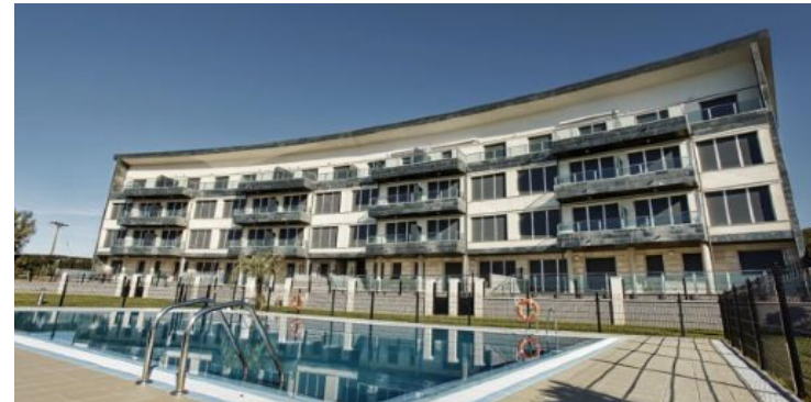
Sector San Pelaio en Bakio 26 viviendas, 32 garajes y 16 trasteros
