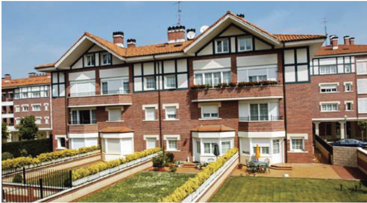
5 viviendas en parcela nº 10 en la UE-CR 22 Galdakao 5 viviendas, garajes y trasteros
