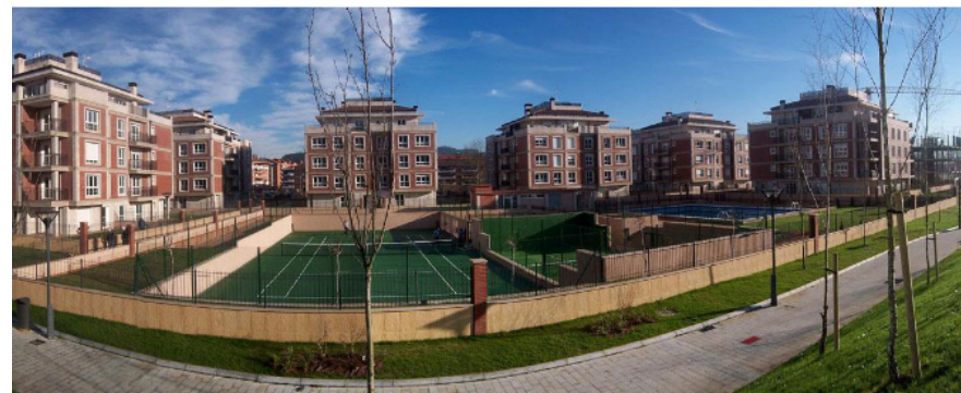
Sector Izar de Amorebieta (Fase 1, 2 y 3) 278 viviendas, garajes y trasteros
