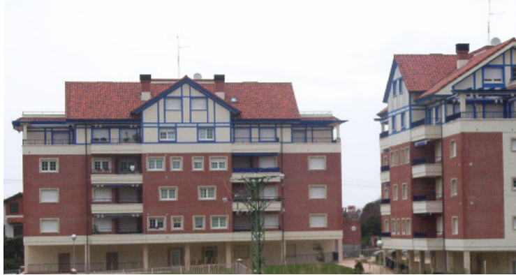
Sector U.E. S.U.R.2 – Areagas en Bakio (Fase 1) 40 viviendas, 113 garajes, 93 trasteros y 2 locales
