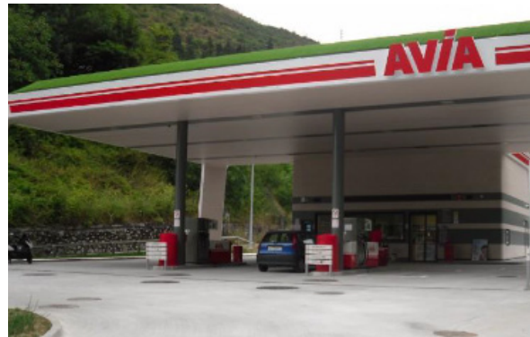
Estación de Servicio Avia en Bergara Superficie: 1.508 m 2 Superficie tienda: 107 m 2
