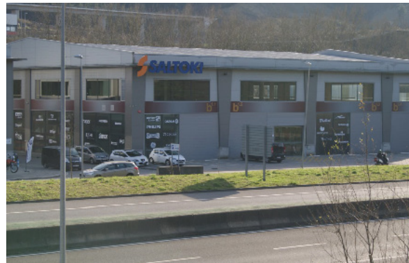
Polígono Guturribai en Galdakao: Nave B1 Superficie: 1.800 m 2
