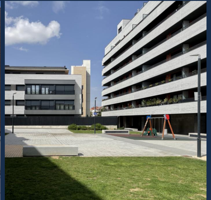
Año 2017: Residencial Conjunto viviendas Cellophane. Burgos
