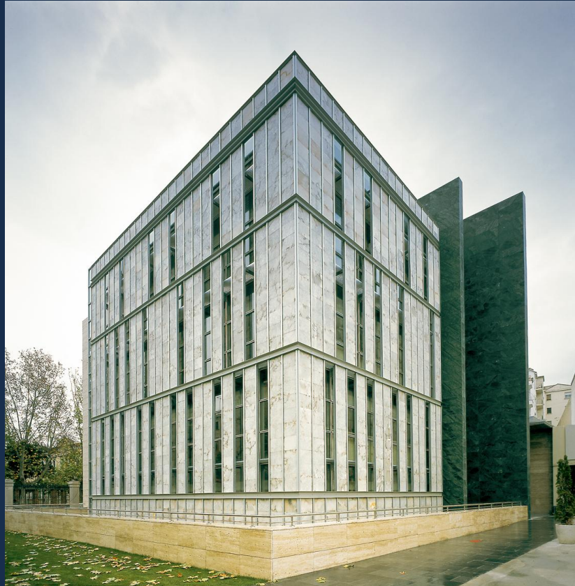
Año 1999: Edificio Administrativo . Logroño
