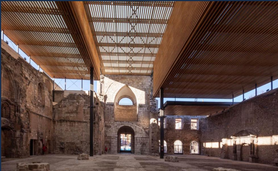
Año 2018: Cubierta monasterio San Juan. Burgos
