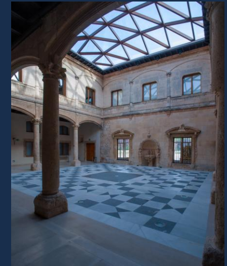
Año 2014: Cubierta Palacio Saldañuela. Burgos
