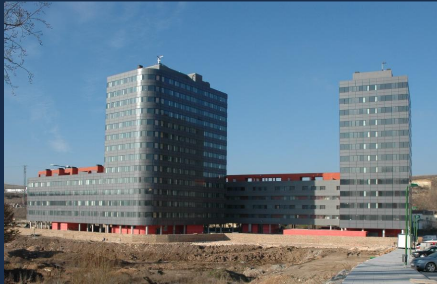
Año 2003: Conjunto 168 viviendas. Burgos
