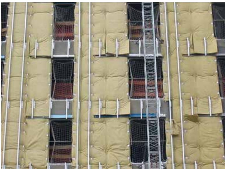
soluciones que puedan propagar el fuego en la envolvente de los edificios y optar por materiales, como es el caso de las lanas minerales, que contribuyen tanto a un mejor aislamiento del frío, del calor y del ruido como a una mayor protección contra el fuego, al tiempo que son respetuosas con el medio ambiente.
