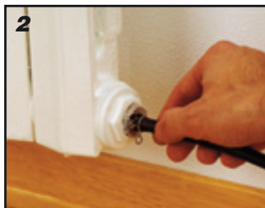
2 Avvitare il tubetto di scarico in dotazione
