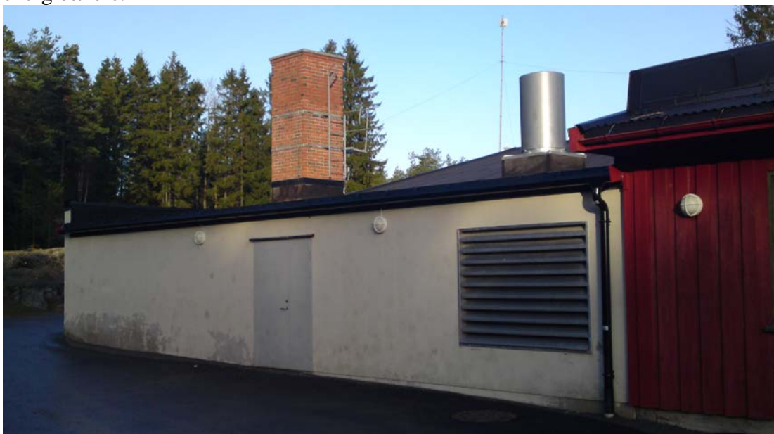
Fyrrom Våk skole, med varmepumpe, oljekjele og luftinntak friskluft, høsten 2011. Foto: SOM
