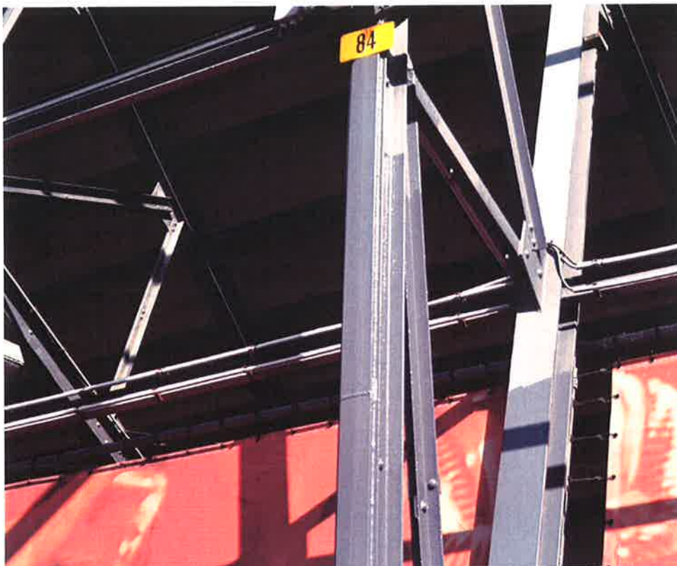
Foto 5: Onderhoud aan de coating op de spanten
